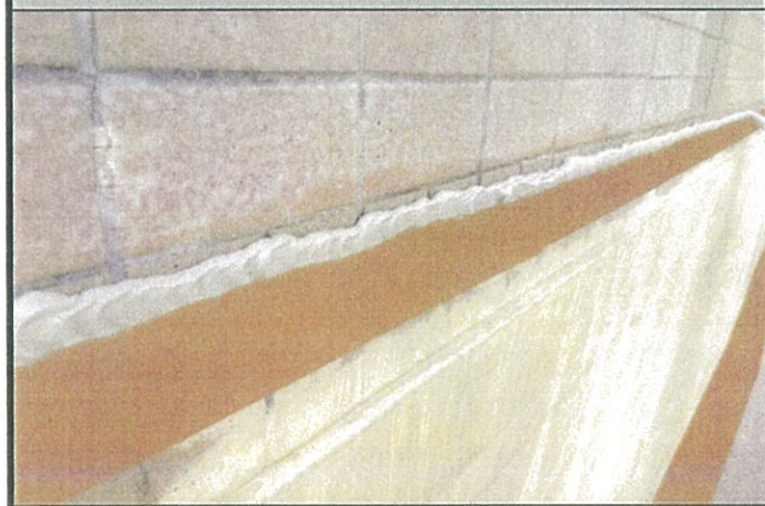
⑤ラッピング部の最上部に剥離シールを打つ(雨養生) ※そのまま72~168時間以上放置する。
