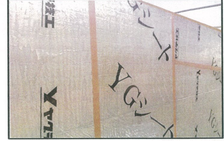
④ラッピングしたらガムテープ(50mm幅)でYGシートの重ね部を全て貼り合わせる。 (雨水、風が入り込まないようにする為)
